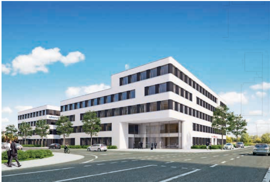
Ansicht der Hauptseite des Advancis-Campus.
