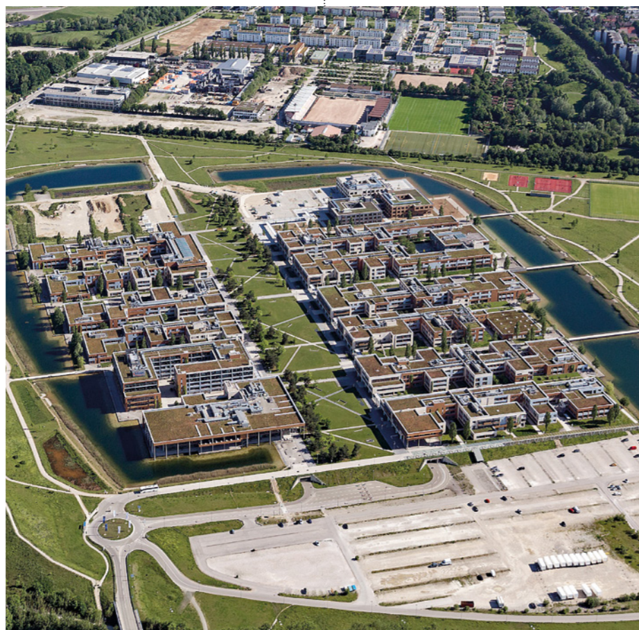
Luftbild "Campeon" Neubiberg Bild: mw-luftbild.de
